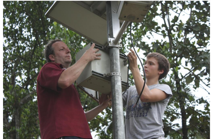
Montage einer Straßenlaterne mit Solarmodul als Insellösung
